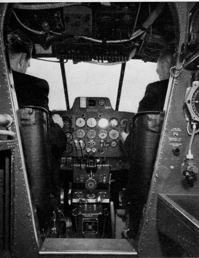
Abb. 3. Die vielen Instrumente, Knöpfe und Hebel der Beechcraft D-18-S, zweimotoriges Ausbildungsflugzeug der Reichsluftfahrtschule
