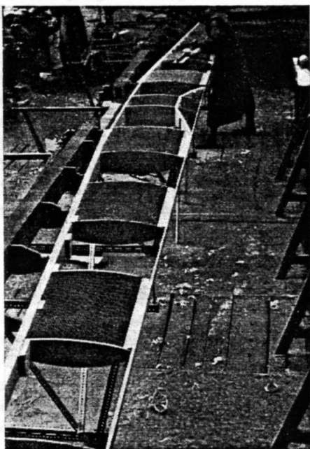
Abb. 12 Flügelkern für das Segelflugzeug D-34 d auf der Schwenk-Helling. Nachstraaken der Wabenfüllung
